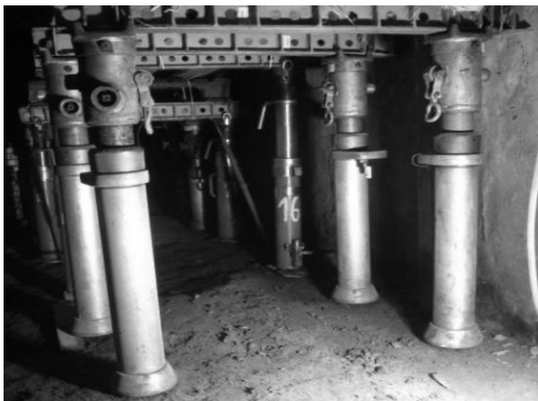
Rys. 1. Odrzvia obudowy chodnika ratowniczego ze stojakami firmy Salzgitter-Dowty [2]
